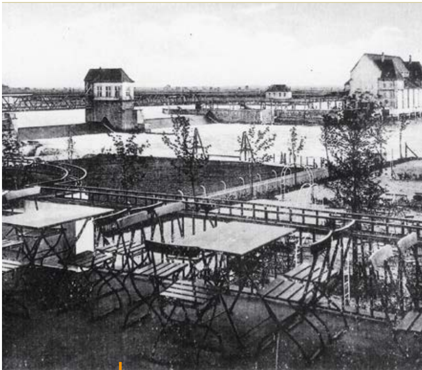
Blick auf das Weserwehr vom damaligen Wehrschloss aus und Bau der Schleusenanlage im Jahr 1908.
